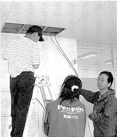
ネットワークづくりで天井に配線する学生
